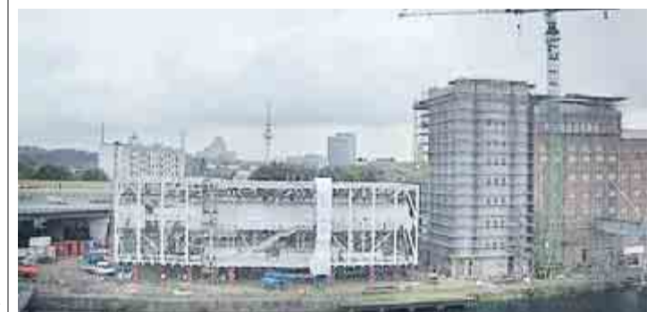
Web-Cam-Foto: die Museumsbaustelle mit der Stahlkonstruktion
